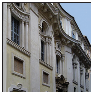
11. kép. A Palazzo di Propaganda Fide oldalhomlokzata.
